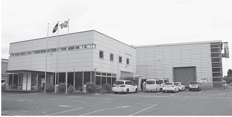
茨城工場の外観。左側が事務所で、右側が製造工場
